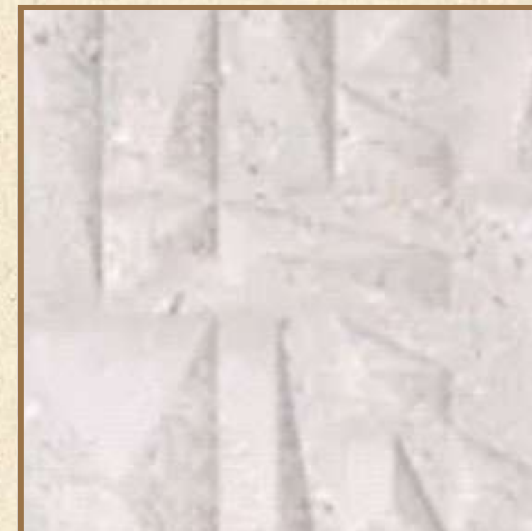
Pared baños de regadera
